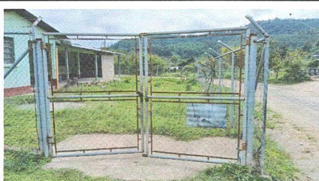
Foto 4: CUBIERTA DE PORTON
