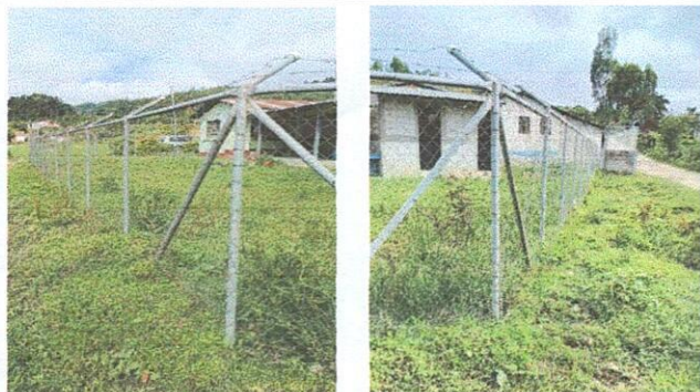
Foto1: MEJORAMIENTO DE MURO PERIMETRAL
