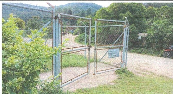
Foto 3: MEJORAMIENTO DE PORTON
